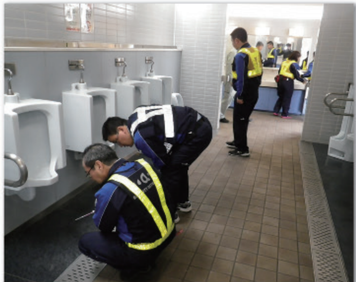
臭気、換気、照明、湿度、不快指数等、多岐にわたる診断項目をチェック
