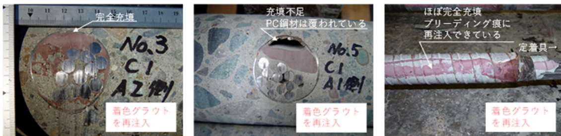
再注入の状況の確認事例
