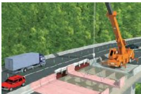
【床版取替施工】
