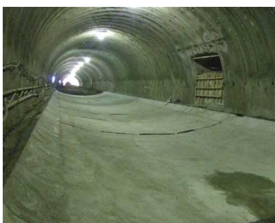
【トンネルインバート設置】
