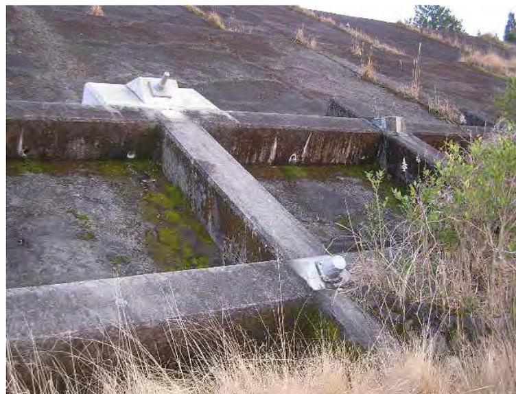
アンカー増打ちなど補強アンカー
