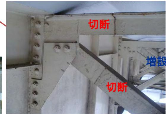
21~25年後 : 対傾構増設と既設対傾構切断
