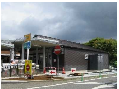
E1 東名高速道路 駒門PA (上り)
