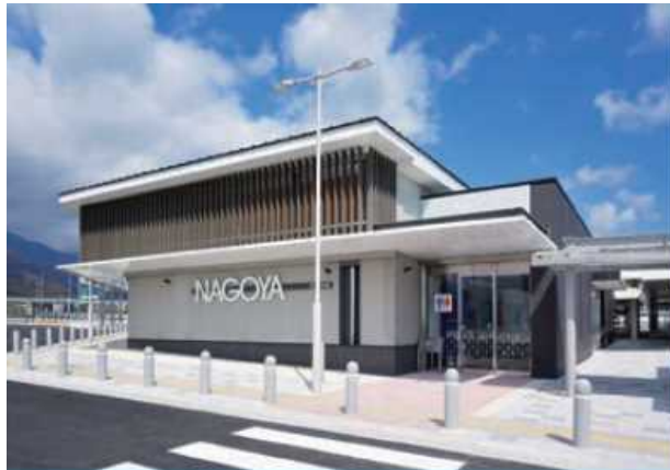
▲E1A新名神高速道路 鈴鹿PA㊧トイレ棟
