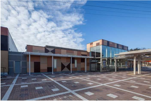
▲E1A新東名高速道路 岡崎SA㊦トイレ棟
