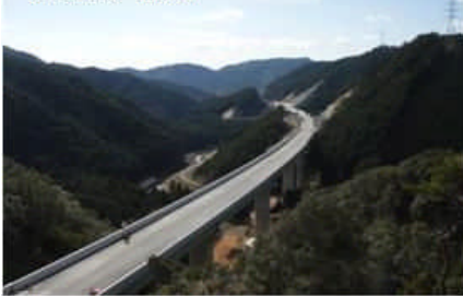
② 小屋ノ谷橋
