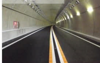
④ 駒トンネル
