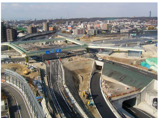
国道302号の建設状況(植田IC付近)
