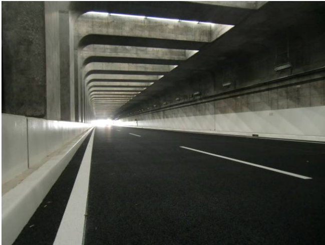
高針JCT～植田IC間[掘割部]
