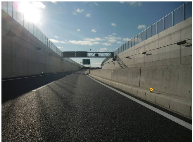
有松IC～名古屋南JCT間[橋梁と掘割の移行部]
