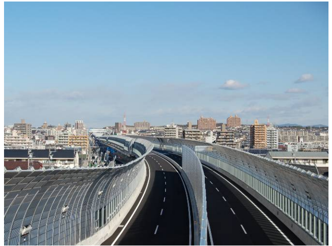
植田IC～鳴海IC間[橋梁部]
