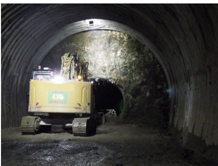
避難連絡坑拡幅工事のイメージ
