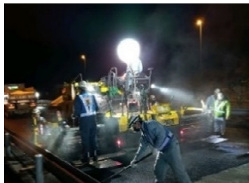
舗装補修工事
