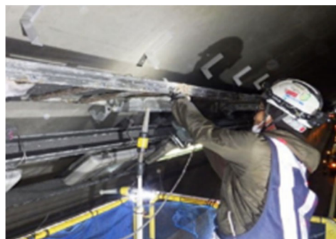
トンネル照明設備点検
