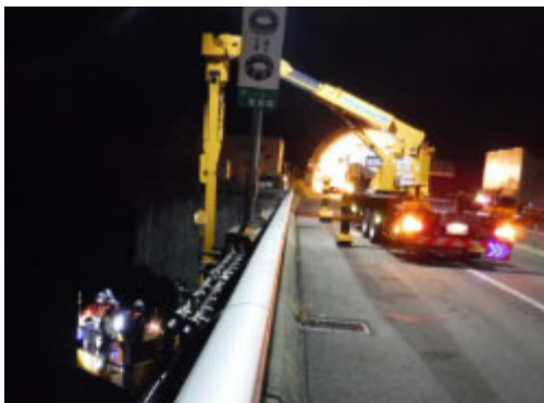
特殊点検車両による橋梁点検
