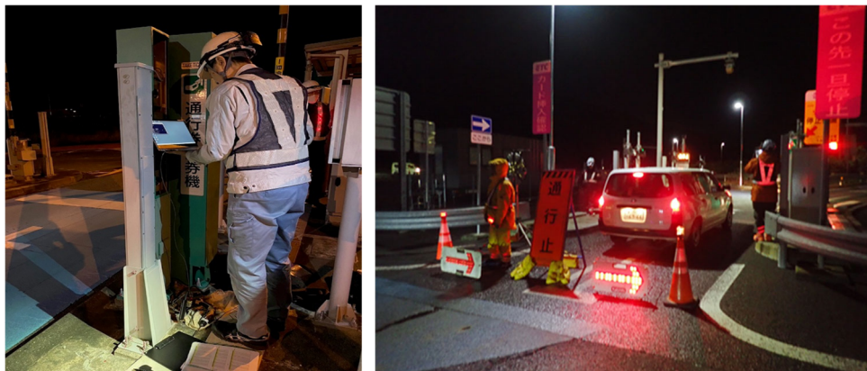
ETC 設備の改造工事
