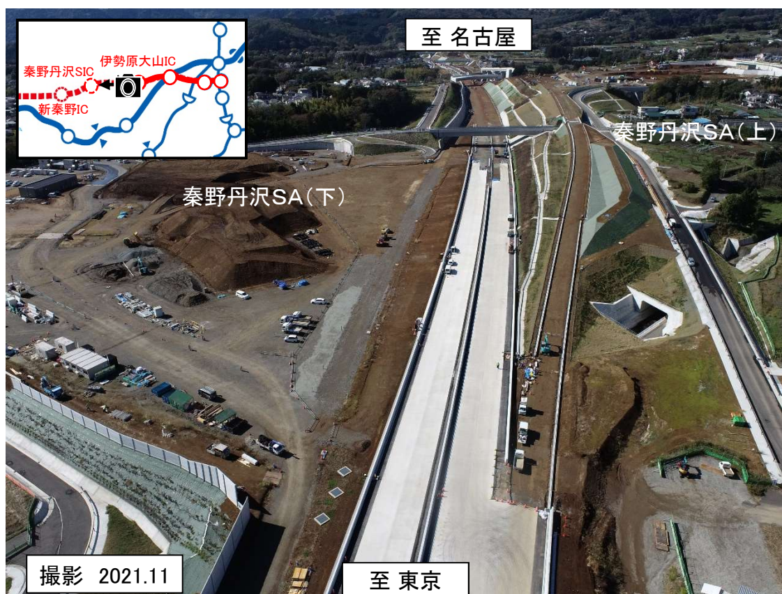
秦野丹沢SA付近現場状況(秦野市域)
