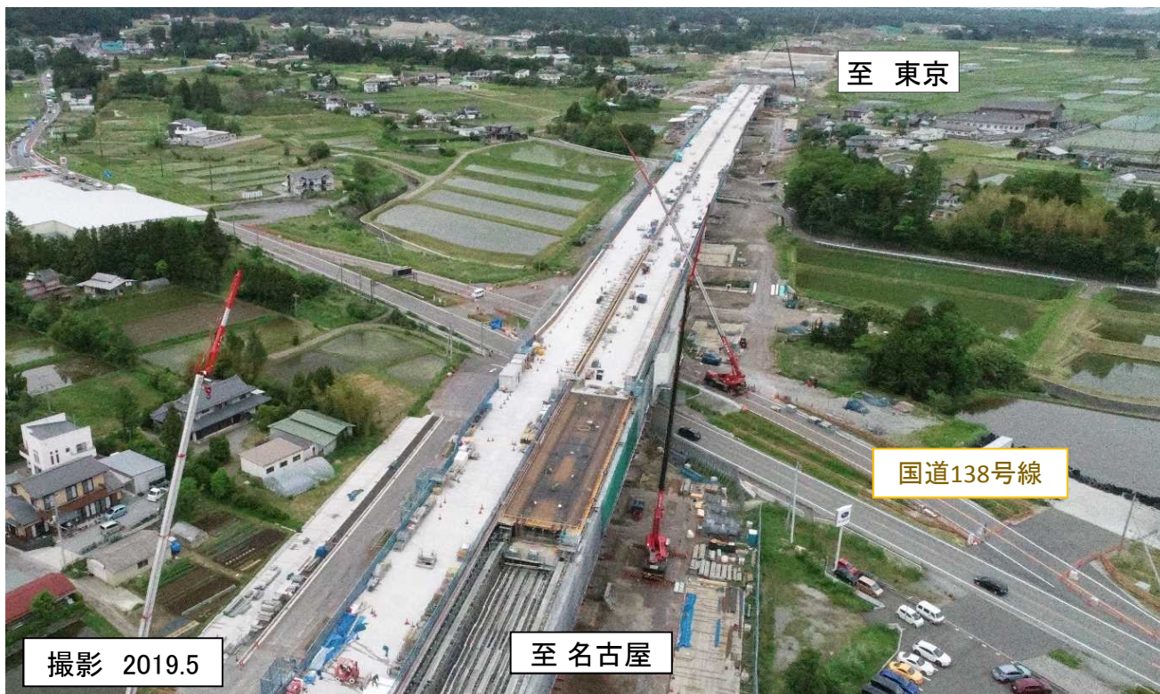
御殿場IC付近 橋梁上部工施工状況(御殿場市域)
