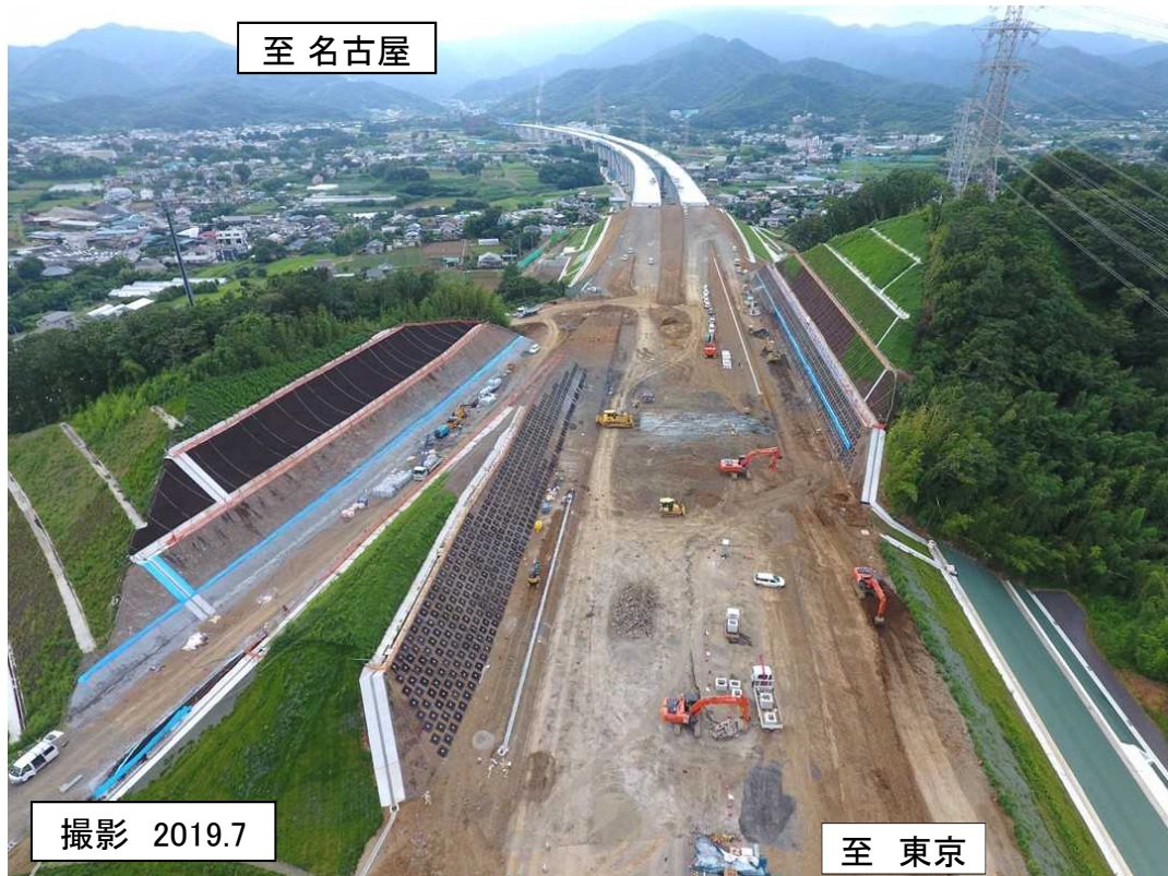
伊勢原JCT付近現場状況(伊勢原市域)
