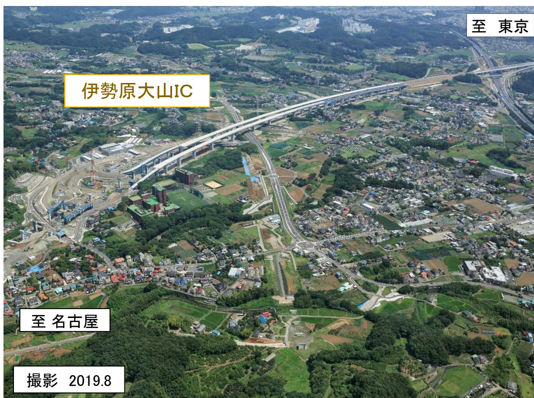
伊勢原大山IC付近現場状況(伊勢原市域)
