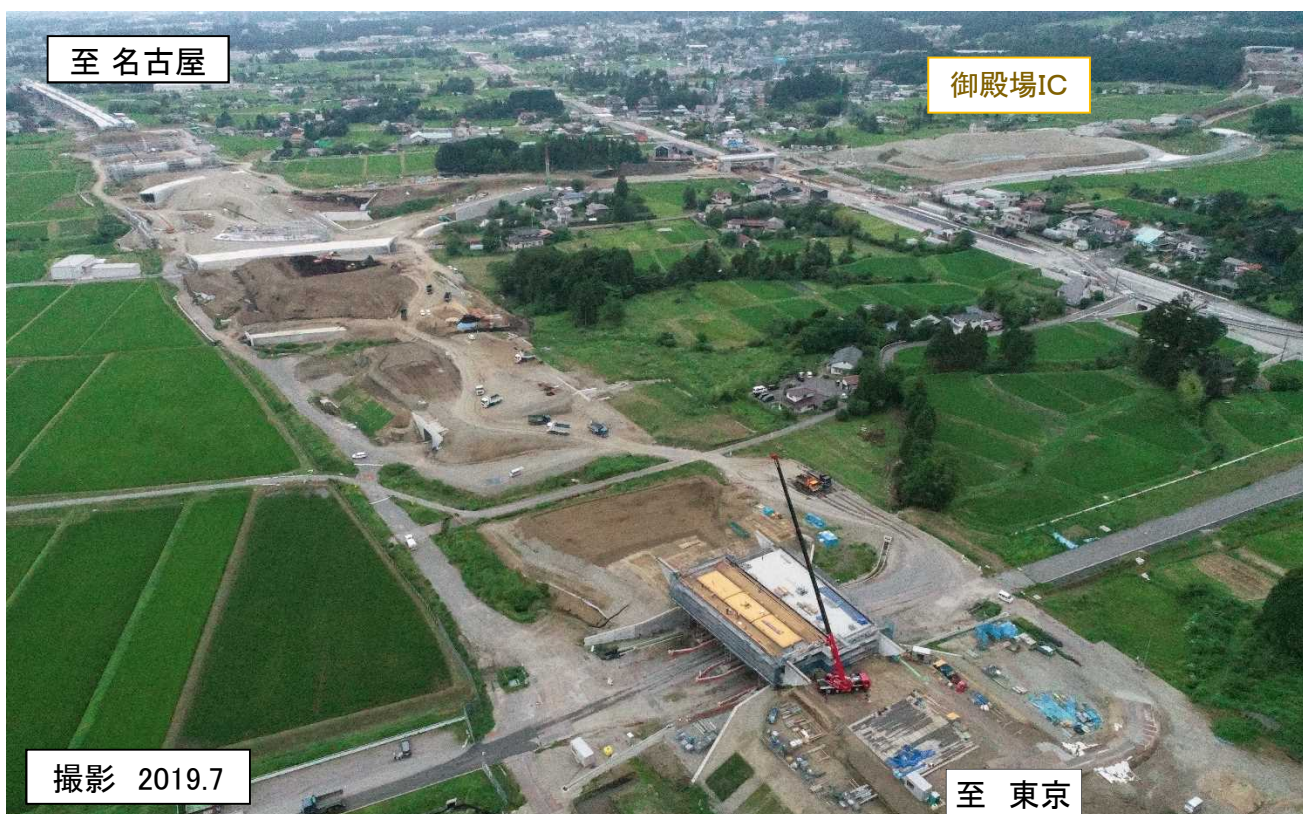
御殿場IC付近 土工部施工状況(御殿場市域)
