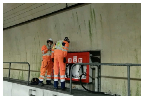
＜トンネル非常用設備の点検状況＞
