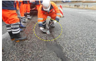
(ポットホールの応急補修)
