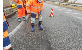
(ポットホールの応急補修)
