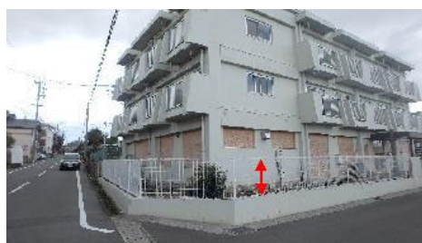
(コンクリートブロック塀取り壊し後)
