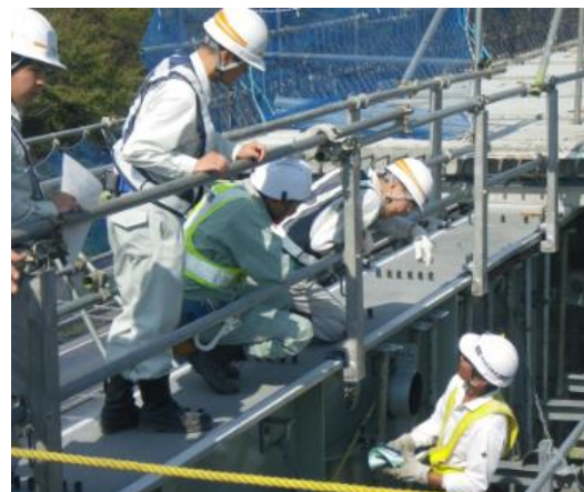
(工事安全パトロールの実施状況)
