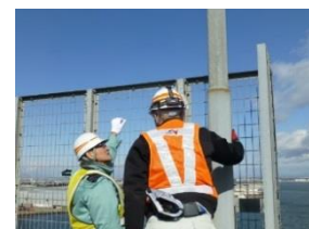
(倒壊標識柱と同一構造の点検)
