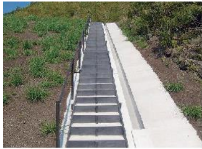
のり面点検路の整備
