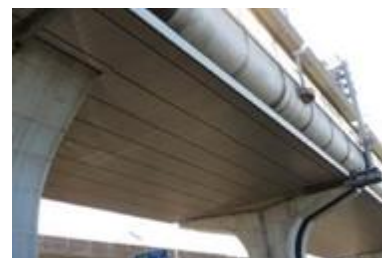
(裏面吸音板の設置状況)
