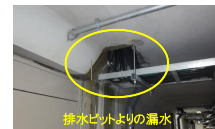
地下通路 雨漏り状況(改定前)
