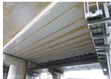
《あと施工アンカーで固定された橋梁の補強鋼板》
