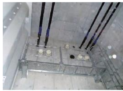
PC橋アンカー定着部に設けた検査路
