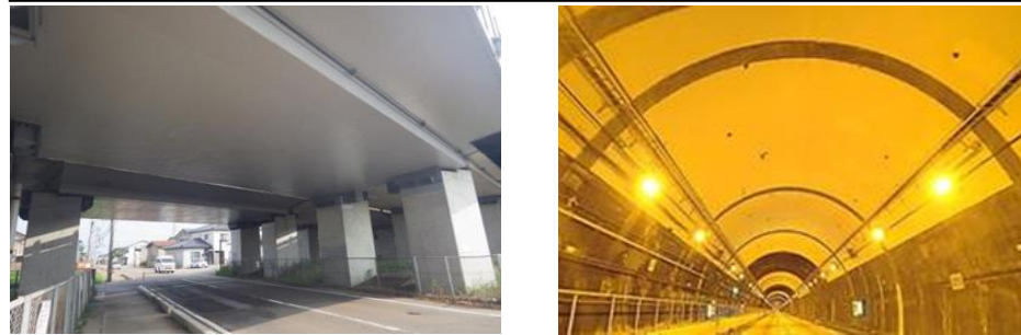
《剥落対策工(連続繊維シート)施工後》
