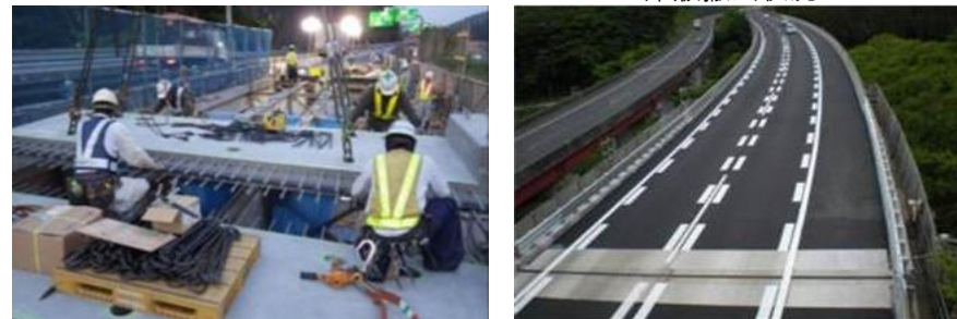
《PC床版施工状況》
