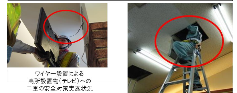
天井点検口を用いた点検状況
