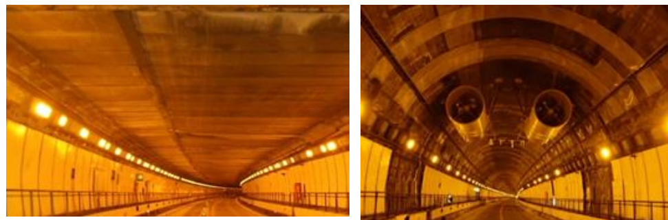
＜天井板撤去前＞
