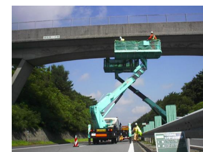
《跨道橋の補修工事》
