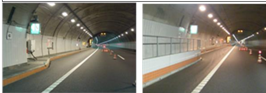
《監視員通路設置前》
