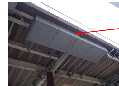
《トールゲート上に設置されたETC電波吸収体》
