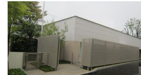
車両室の外観
