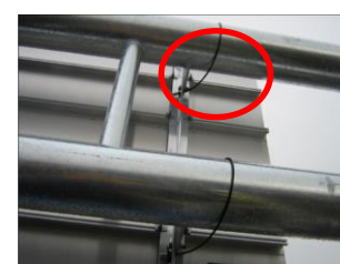
標識板のワイヤーによる二重の安全対策
