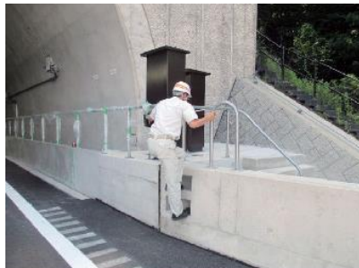
トンネル検査路への昇降階段
