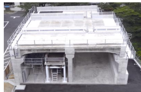
N2U-BRIDGE (ニューブリッジ) 全国で更新に伴い撤去された橋梁を再利用した、名古屋大学構内にある構造物点検の研修施設です。
