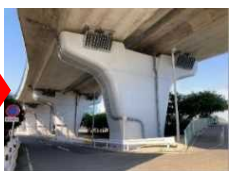
【橋梁における耐震補強工事の施工例】
