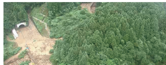
北陸自動車道 敦賀IC～今庄IC間で発生した土石流による被災状況 (2022年8月5日)
