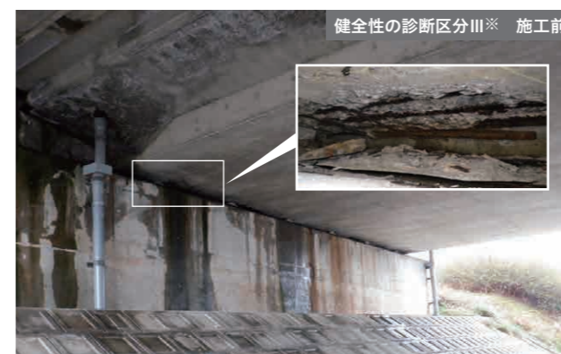
※構造物の機能に支障が生じる可能性があり、早期に措置を講ずべき状態
