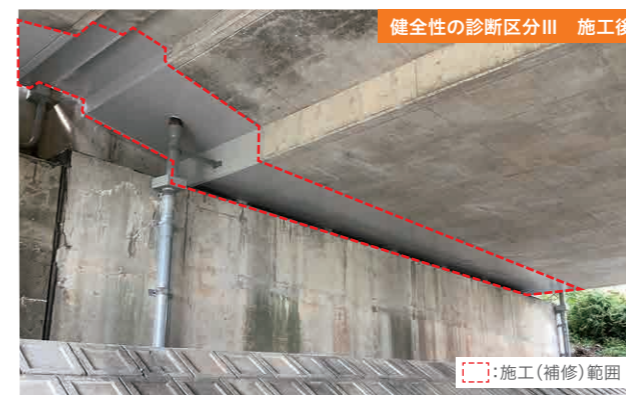
橋梁の継ぎ目部の漏水に対するコンクリート構造物補修工事
