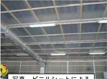
写真 ビニルシートによる飛散防止処理(暫定)
