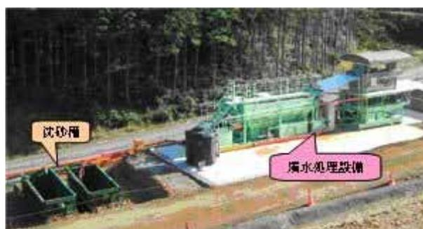
例) 水素イオン濃度 (pH) は 5.8~8.6 の値になるよう pH 調整剤を用いて中和しています。また、汚濁水中に存在する浮遊物質量 (SS) は 200ppm 以下となるよう凝集沈殿させ浮遊物質を取り除いています。
