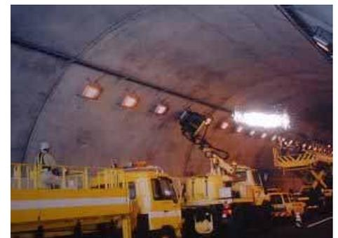
写真 工事状況(照明設備の清掃・交換)
