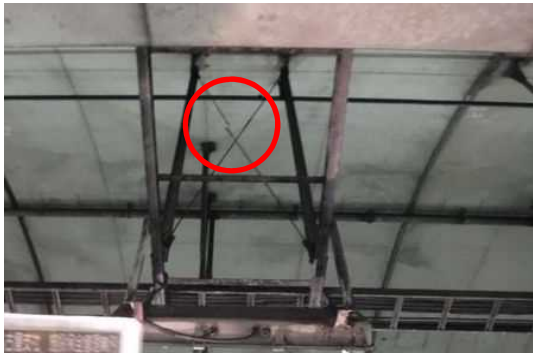
【速やかな対策が必要な変状の措置事例(トンネル照明支持金具ブレースの破損)】
