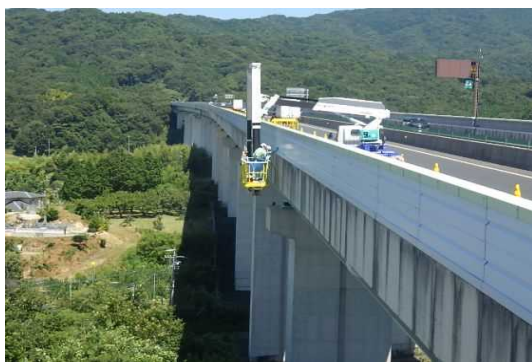
【橋梁における点検実施状況】
