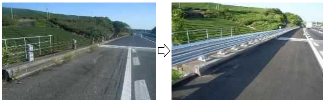
【防護柵の改良状況】
