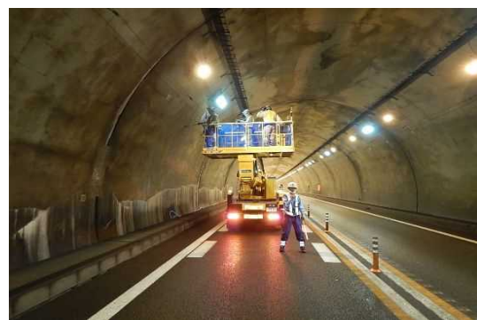
【トンネルにおける点検実施状況】
