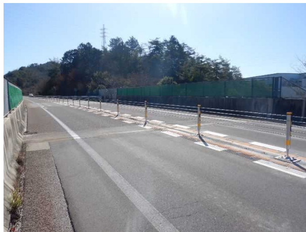
【中小橋区間(C3 東海環状道 関テクハイ橋)】
