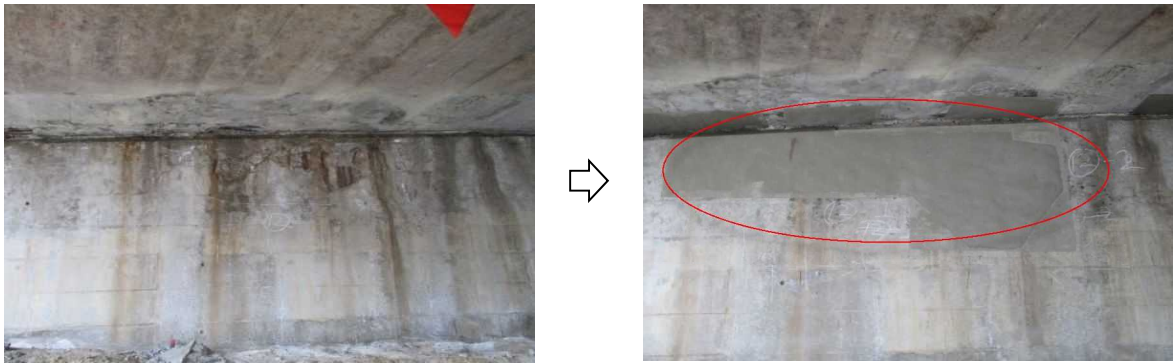
【診断結果Ⅲとされた施設の修繕事例(橋台コンクリートの補修)】
