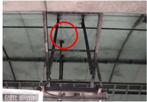
【速やかな対策が必要な変状の措置事例(トンネル照明支持金具ブレースの破損)】
