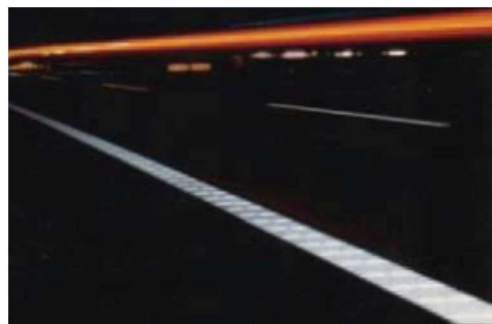
【高輝度レーンマークの整備状況】
