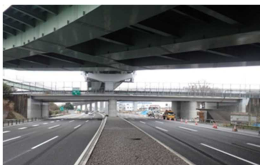
【名神高速道路 市場橋 ロッキング橋脚】
