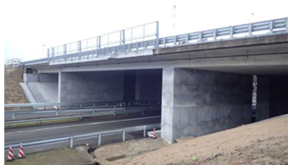
【北陸自動車道 杉崎第二橋 ロッキング橋脚】
