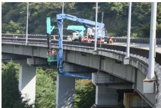
【橋梁における点検実施状況】
