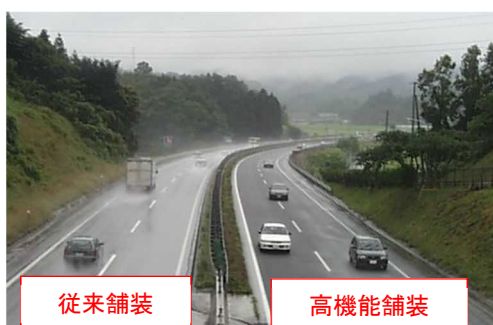
【密粒舗装と高機能舗装の状況】
