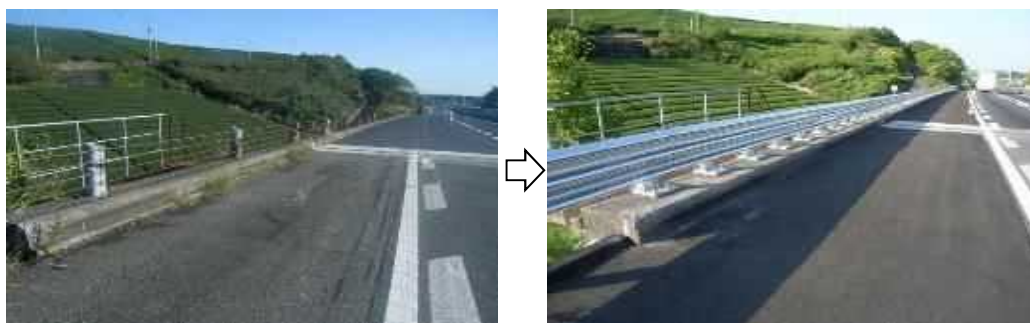
【防護柵の改良状況】
