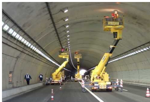
【トンネルにおける点検実施状況】
