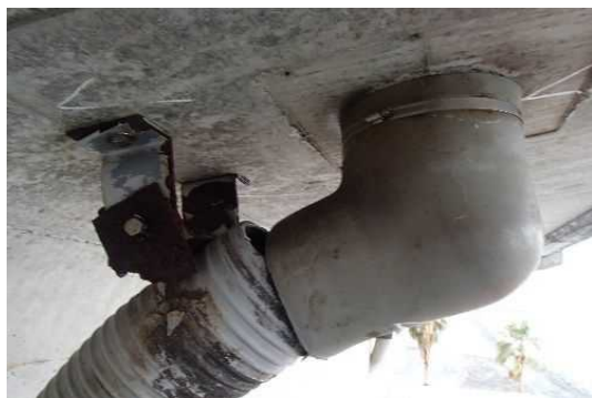
【速やかな対策が必要な変状の措置事例(排水管の変状)】
