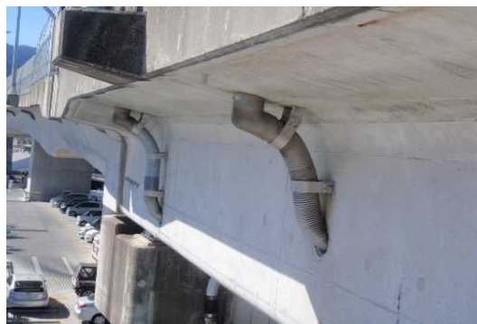
【速やかな対策が必要な変状の措置事例(排水管の変状)】
