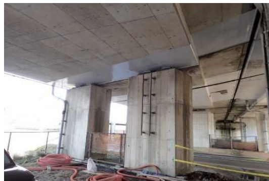
【診断結果Ⅲとされた構造物の修繕事例(橋梁床版コンクリートの補修)】
