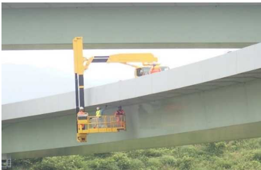
【橋梁における点検実施状況】
