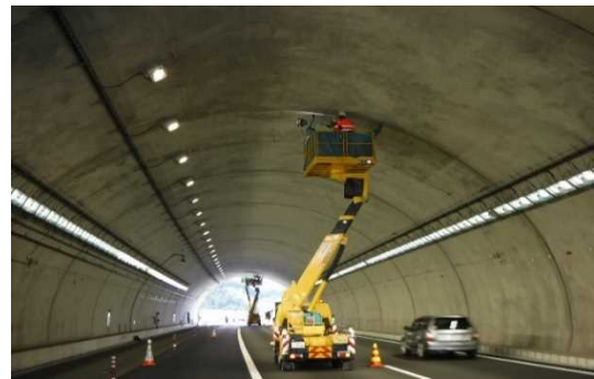
【トンネルにおける点検実施状況】
