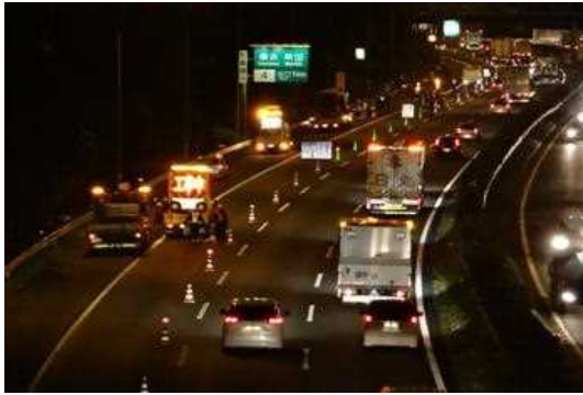
【東名集中工事の規制状況】
