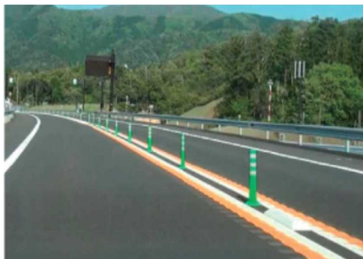
【ラバーポール撤去前】
