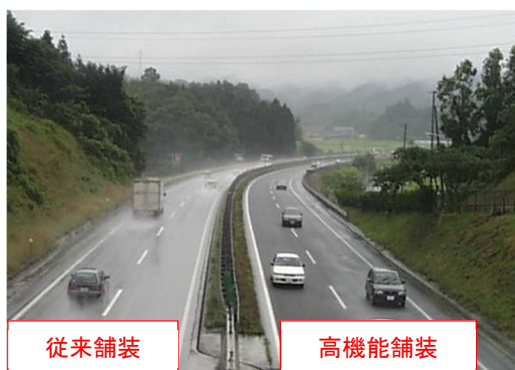
【密粒舗装と高機能舗装の状況】
