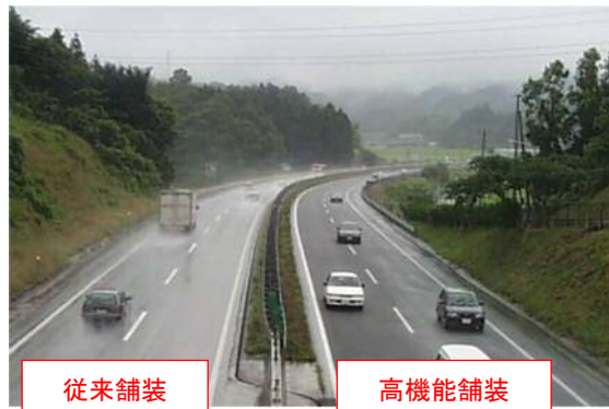
【密粒舗装と高機能舗装の状況写真】
