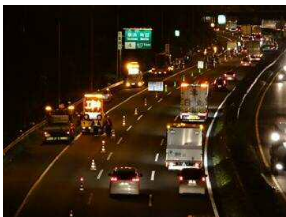
【東名集中工事の規制状況】
