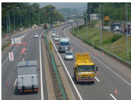
【名神集中工事の規制状況】
