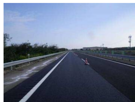
【舗装補修(施工後)】
