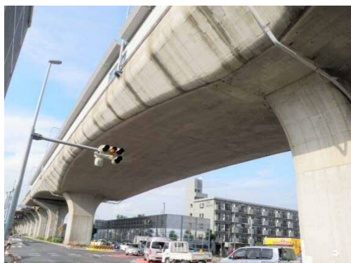
【剥落対策工(連続繊維シート)施工後】
