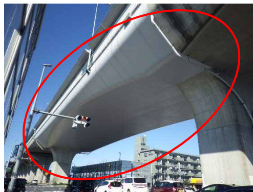
【剥落対策工(連続繊維シート)施工後】
