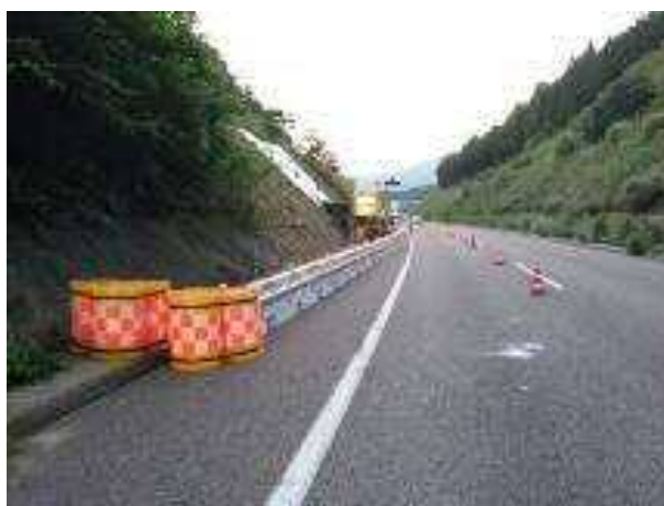
【仮設防護柵設置完了】
