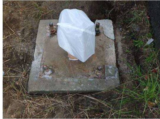
【道路照明支柱の撤去】
