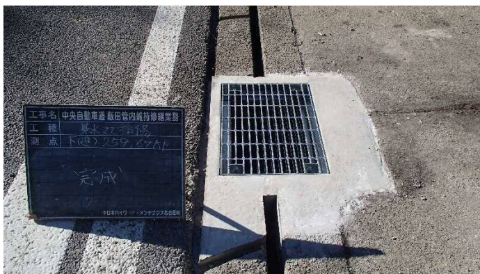
【集水ますの補修(着手後)】
