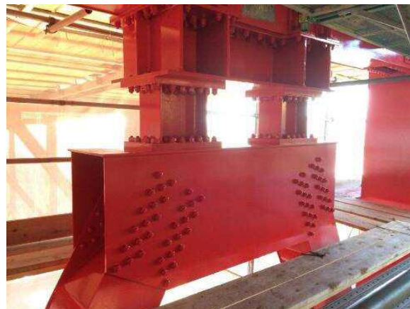
【落橋防止のためのせん断ダンパー部材の設置】
