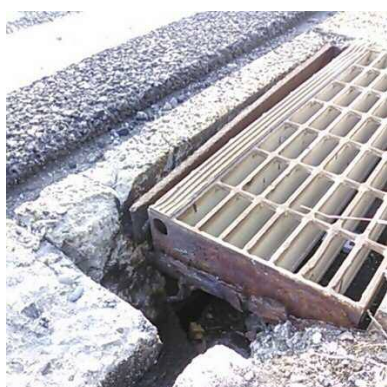
【集水ますの補修(着手前)】
