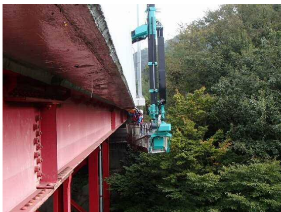
【橋梁における点検実施状況】
