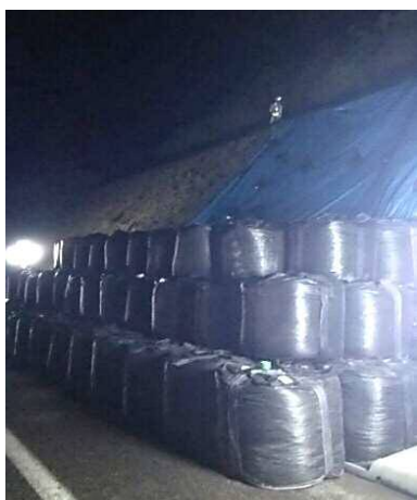
【大型土のう設置完了】
