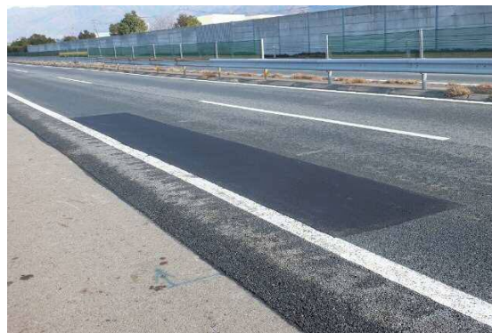
【舗装打替え後】
