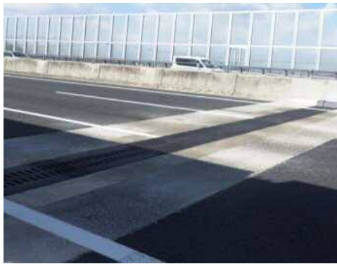
【橋梁計画保全の事例(伸縮装置の補修)】
