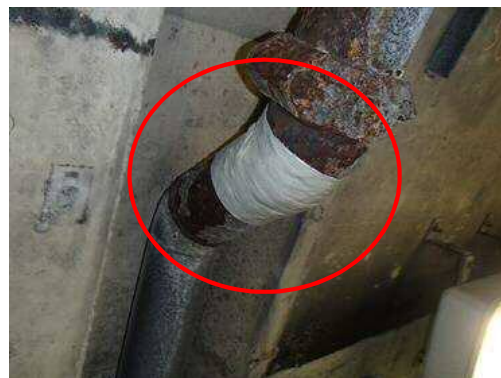
【防食テープにて仮処理】
