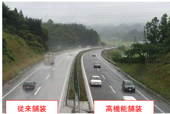
【密粒舗装と高機能舗装の状況写真】
