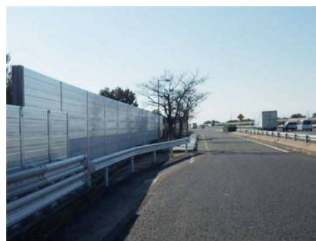
【遮音壁 施工後】
