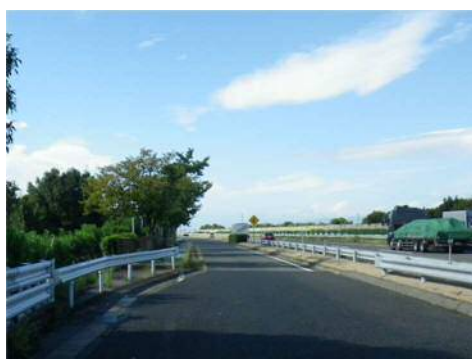
【遮音壁 施工前】
