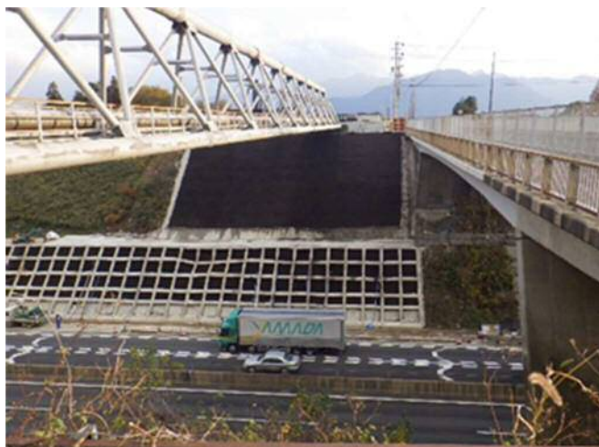
【復旧工事完了(平成28年2月)】
