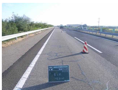
【舗装補修(施工前)】
