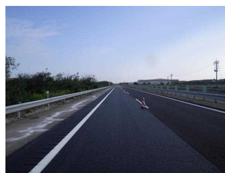
【舗装補修(施工後)】
