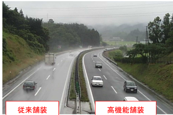
【密粒舗装と高機能舗装の状況写真】
