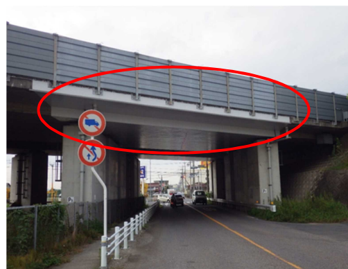
【剥落対策工(連続繊維シート)施工後】
