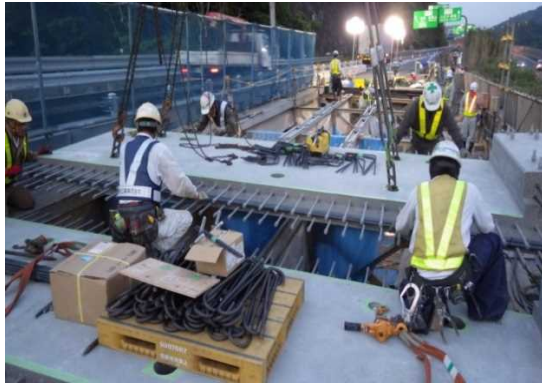
【橋梁の床版取替え工事状況】
