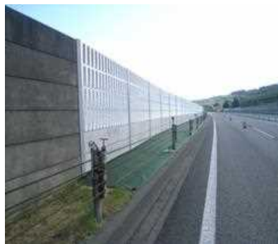
遮音壁 施工後
