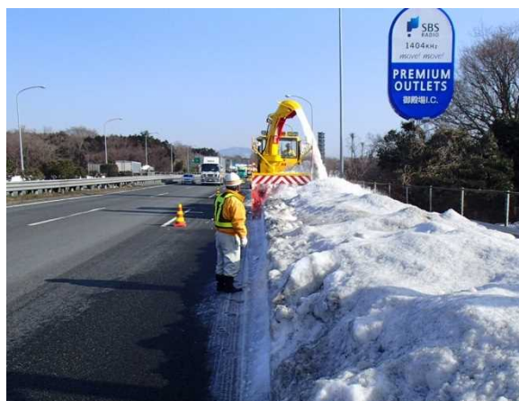
排雪作業状況(東名御殿場地区)
