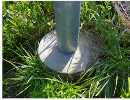
《施設の補修状況 補修後》
