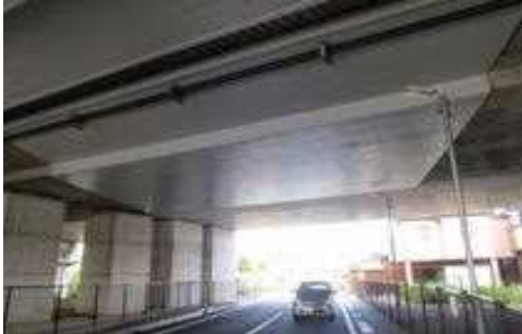
【剥落対策工(連続繊維シート)施工後】
