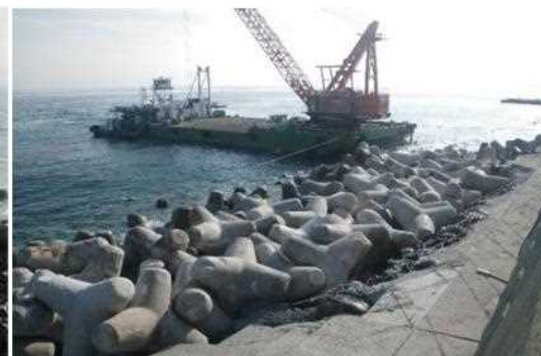
追加応急復旧対策完了
