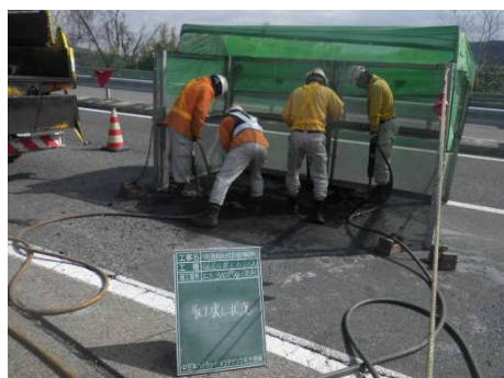
《舗装補修 はつり工》
