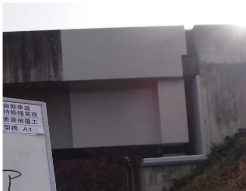
《橋梁計画保全の事例(桁端部の補修)》
