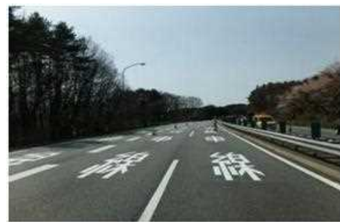
【標識撤去後(路面標示設置)】
