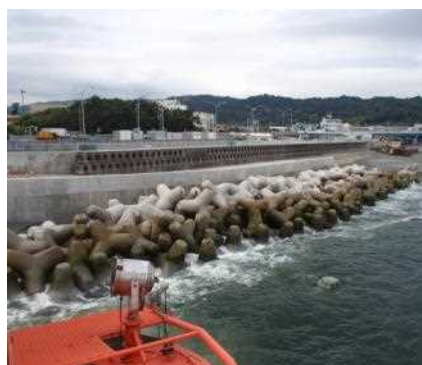
復旧後の護岸工(海上より望む)
