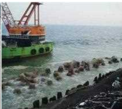
消波ブロック設置完了
