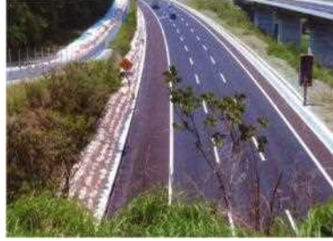
応急復旧状況
