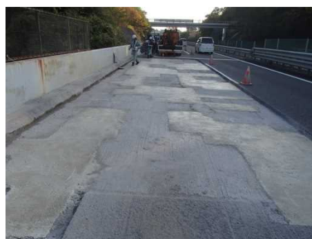
《橋梁床版補修 施工後》
