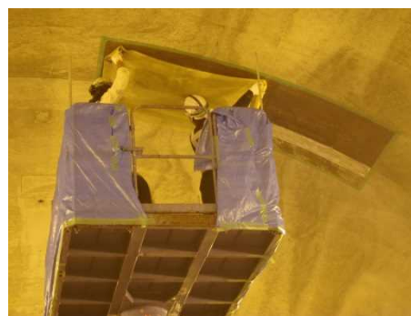
《トンネル補修 はく落シート貼付工》
