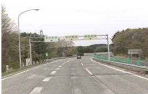
【道路上を跨ぐ標識(撤去前)】
