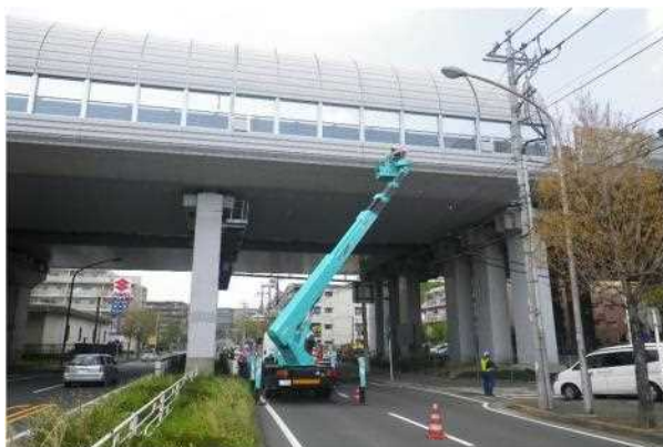
《詳細点検の状況》
