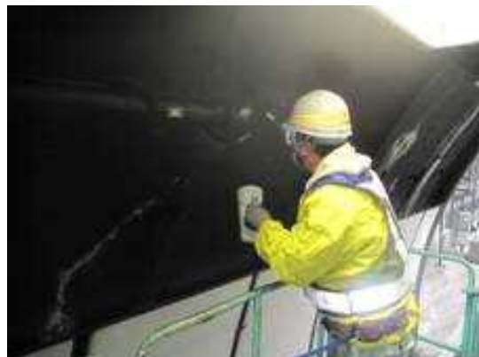
《施設構造検査の状況》
