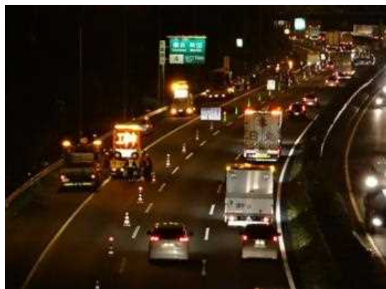
<東名集中工事の規制状況>
