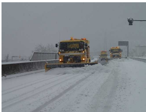
除雪作業状況(東名富士地区)
