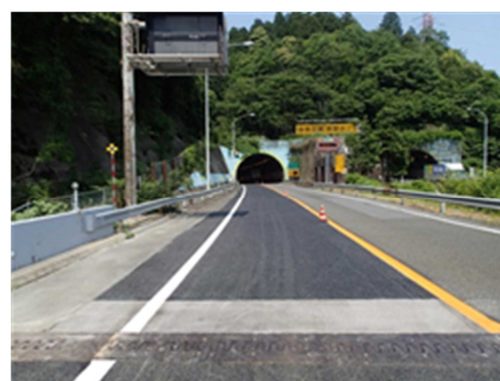
《舗装補修(施工後)》
