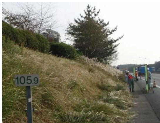
草刈作業(東名愛鷹PA付近)
