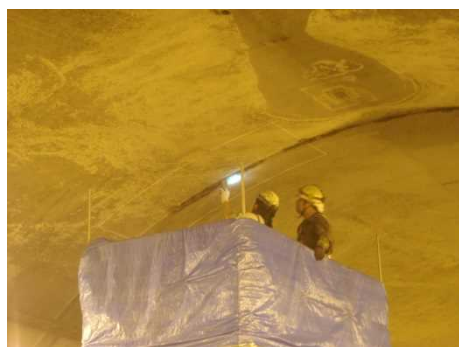
《トンネル補修 断面修復工》
