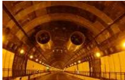
【天井板撤去後(ジェットファン設置)】
