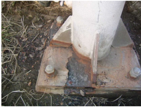
《施設の補修状況 補修前》
