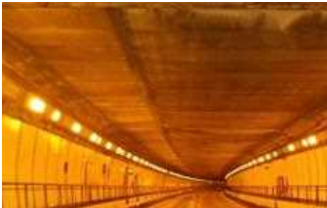
【天井板撤去前】
