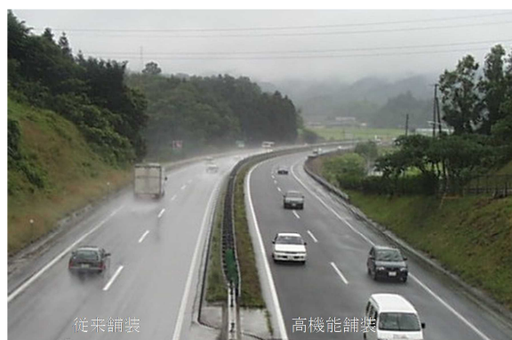
《密粒舗装と高機能舗装の状況写真》
