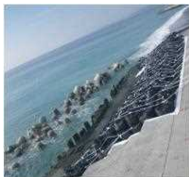
大型土のう設置完了
