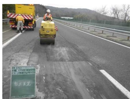
《舗装補修 転圧状況》
