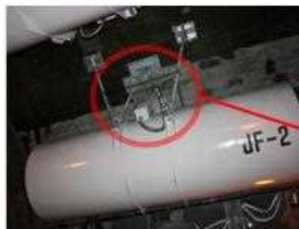
ジェットファンの取付状況
