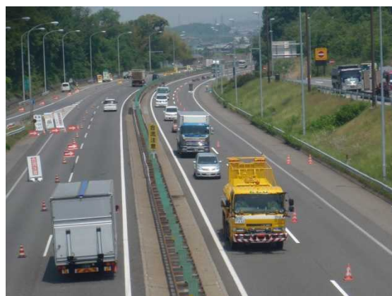
<名神集中工事の規制状況>
