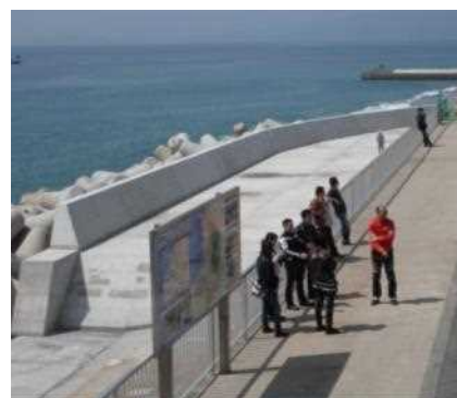
復旧後の護岸工(PA より望む)
