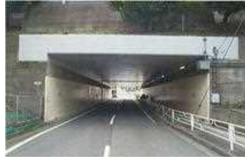
【剥落対策工(連続繊維シート)施工後】
