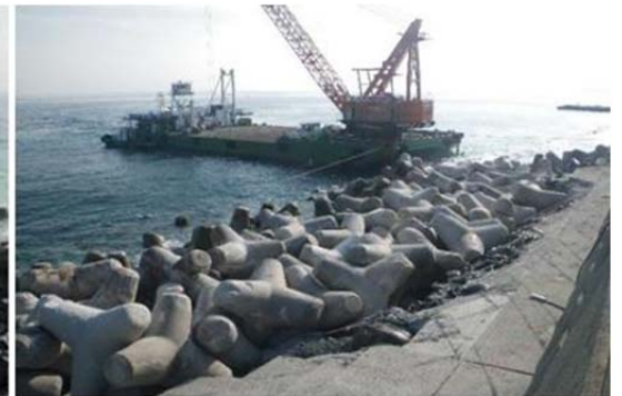
追加応急復旧対策完了
