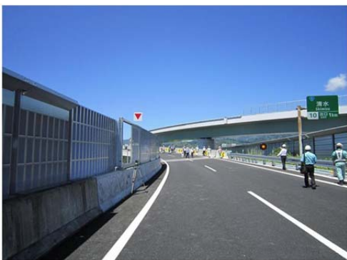
ランプを 2 車線⇒1 車線運用に変更及び導流レーンマーク等実施状況
