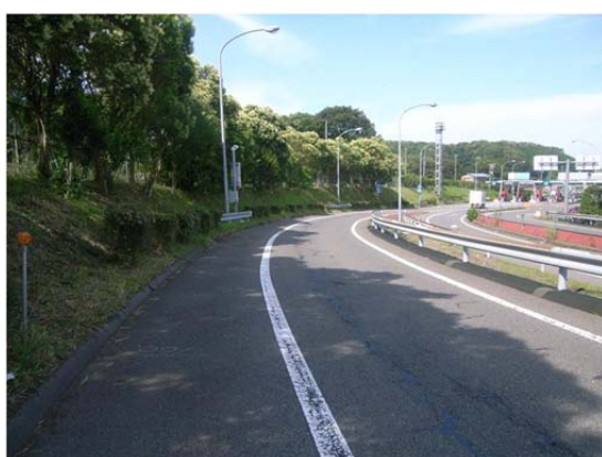
《舗装補修(施工前)》
