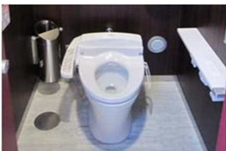
大便器の洋式化及び 洗浄器付便座
