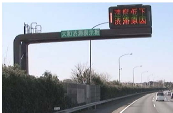
LED標識による速度低下抑制対策(常設化)
