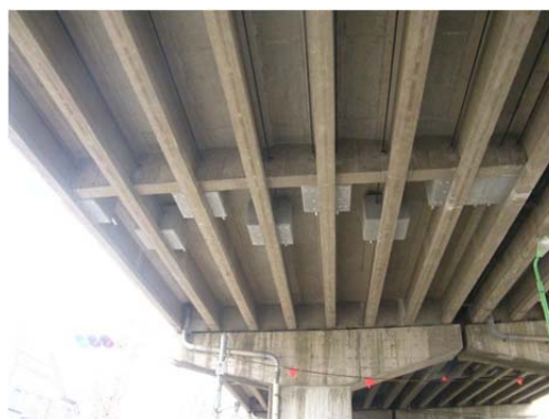
《補修事例(アウトケーブル補強)》
