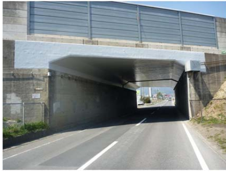
《部分対策(断面修復+剥落繊維シート)》
