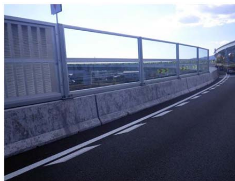
透光遮音壁による視認性向上対策状況
