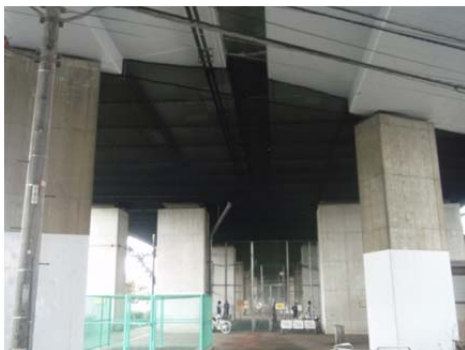
《剥落防止ネットの連続施工》
