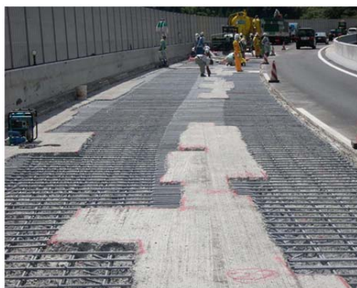
《橋梁の補修状況》
