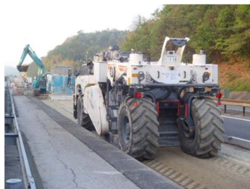
《舗装の深層部補修事例》
