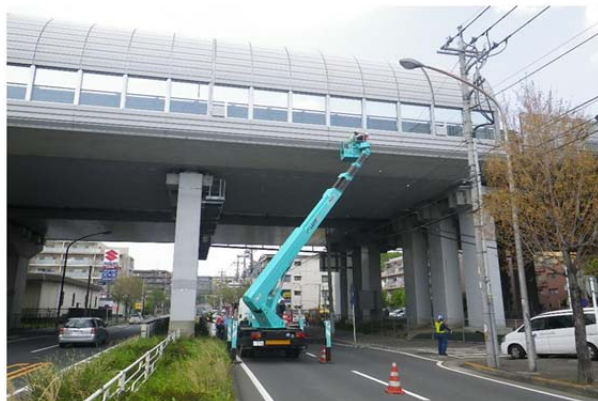
《詳細点検の状況》
