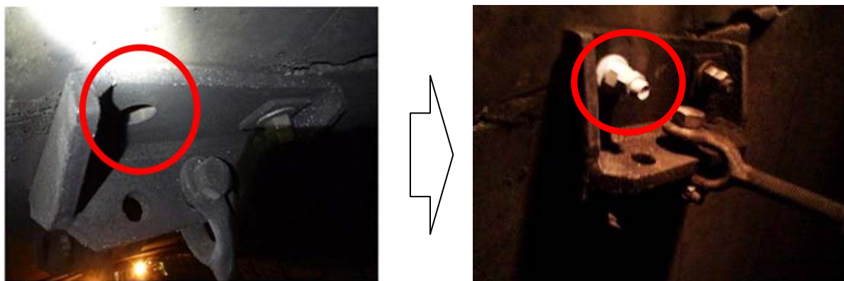
換気用ダクトの吊り下げ金具用アンカーボルトの欠落のため、ボルトを打設
