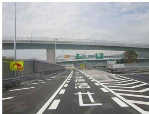
ランプを 2 車線⇒1 車線運用に変更及び導流レーンマーク等実施状況
