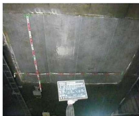
《トンネルの補修状況》
