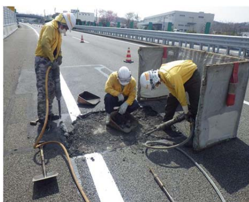
《舗装の補修状況》
