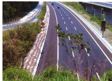
応急復旧完了
