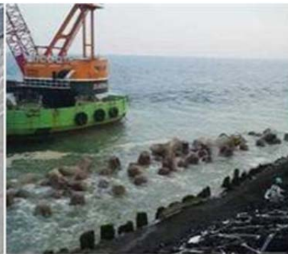
消波ブロック設置完了
