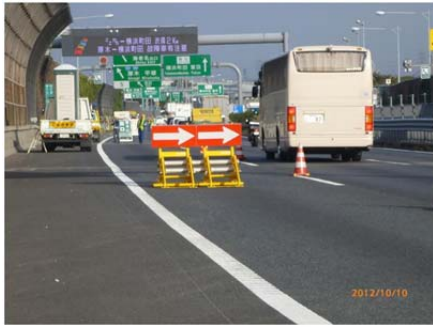
<東名集中工事の規制状況>
