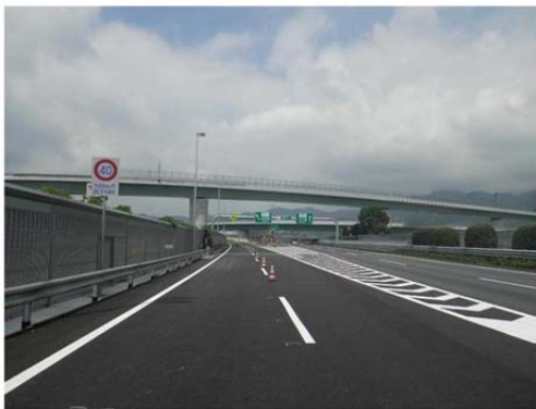
ランプを 2 車線⇒1 車線運用に変更及び導流レーンマーク等実施状況
