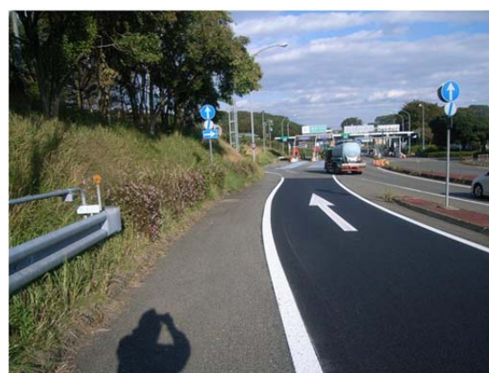
《舗装補修(施工後)》
