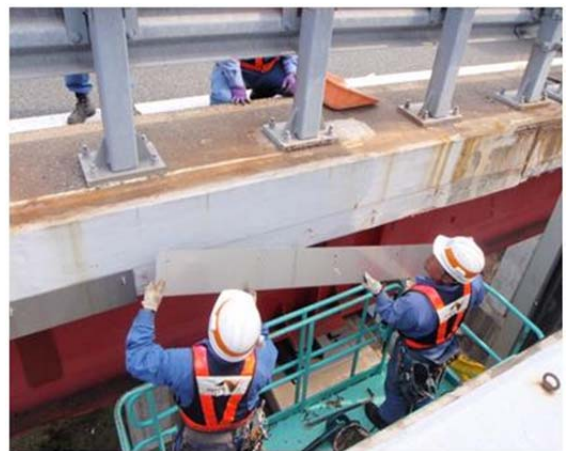
《橋梁付属物撤去状況》
