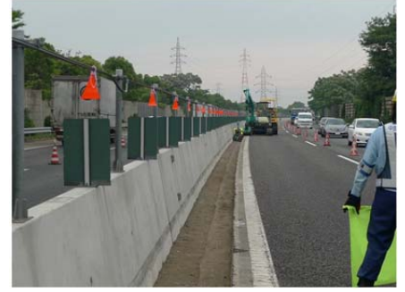
<東名阪・名二環 リフレッシュ工事の規制状況>
