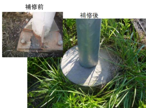
《施設の補修状況》
