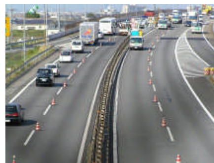
<東名阪リフレッシュ工事の規制状況>
