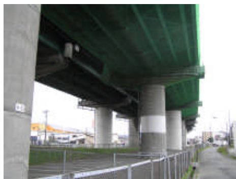
《剥落防止ネットの連続施工》
