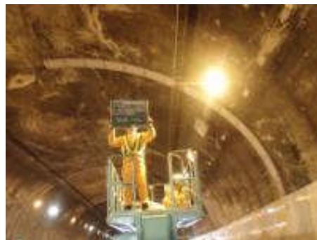
《トンネル目地部剥落防止樋》
