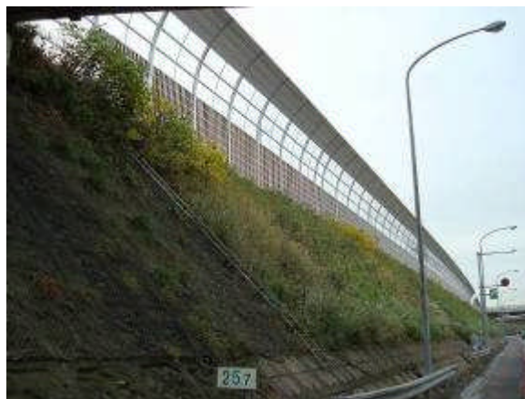
《遮音壁(施工後)》
