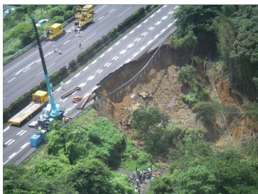
応急復旧作業中
