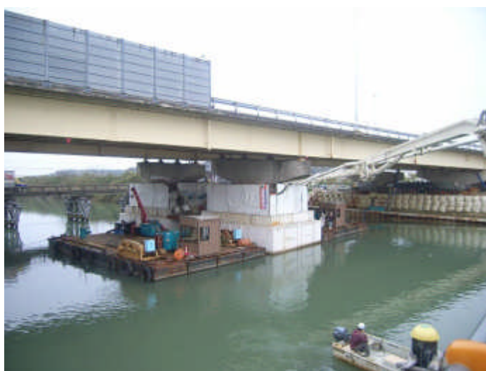
【北陸自動車道 大聖寺川橋における橋脚補強の施工状況】
