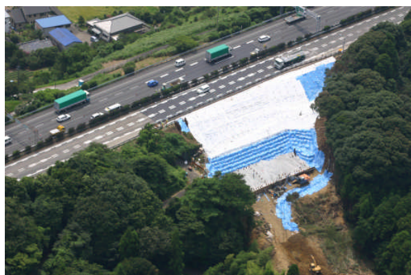
応急復旧完了
