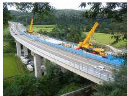
北陸道渋江川橋(下り)床版取替状況
