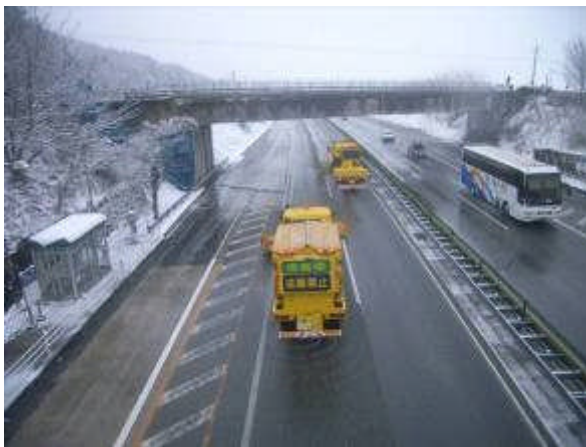
凍結防止剤散布状況 (中央自動車道上り228.1KP付近)
