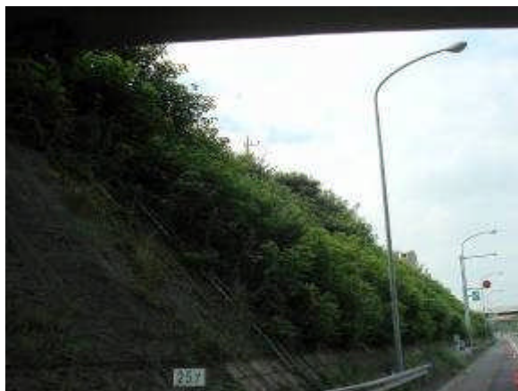
《遮音壁(施工前)》
