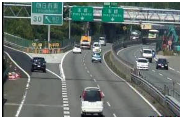
施工前(上り 四日市東インター)
