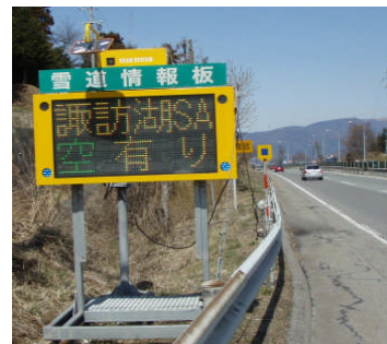
<休憩施設混雑情報板設置>
