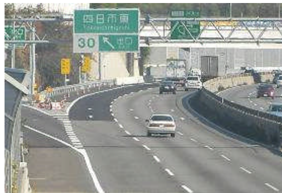
施工後(上り 四日市東インター)
