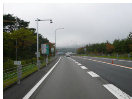
《お知らせアンテナの設置例 東富士五湖道路:須走IC》
