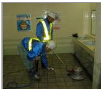
床滑り止め処理
