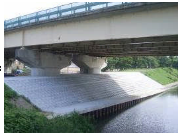
《橋脚補強(施工後)》
