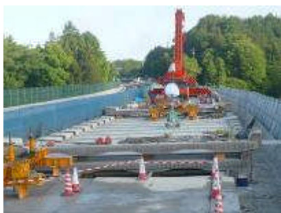
中央道立場川橋(上り)床版取替状況
