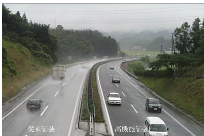
《密粒舗装と高機能舗装の状況写真》
