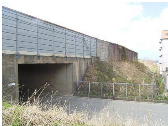
《樹林化（施工前）》
