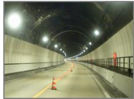
《蛍光灯照明の状況》
