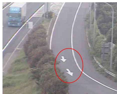
路面表示(矢印)の設置
