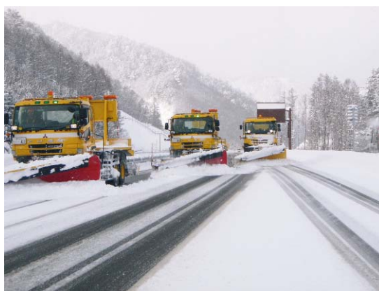
除雪作業状況 (東海北陸道下り97.8KP付近)
