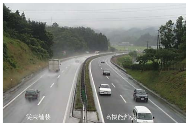
《密粒舗装と高機能舗装の状況写真》
