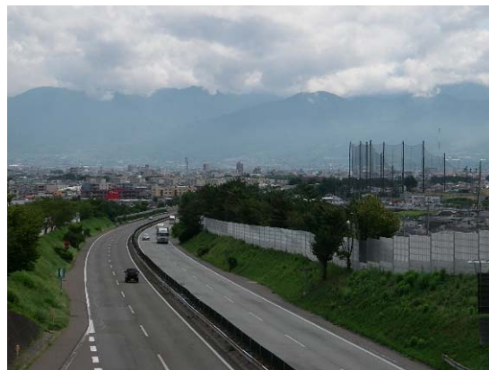
《遮音壁（施工後）》
