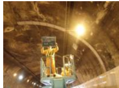
《剥落防止ネットの連続施工②》
