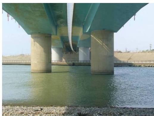
《橋脚補強 (施工前)》
