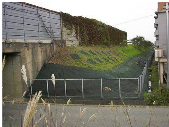
《樹林化（施工後）》
