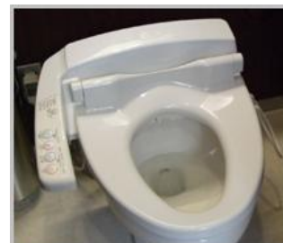
大便器の洋式化及び 洗浄器付便座
