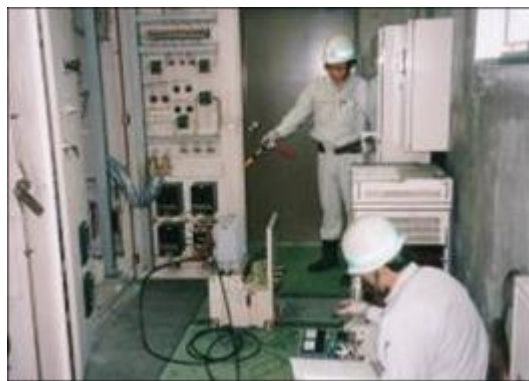
《施設設備点検》
