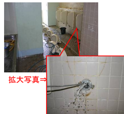
便器を取り外し 排水管の洗浄
