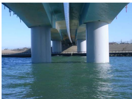
《橋脚補強 (施工後)》
