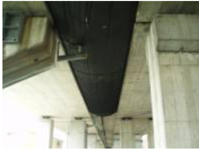
《剥落防止ネットの連続施工①》
