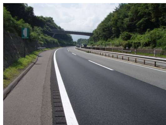
《舗装補修(施工後)》
