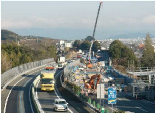
【図20 工事状況(床版取替)】
