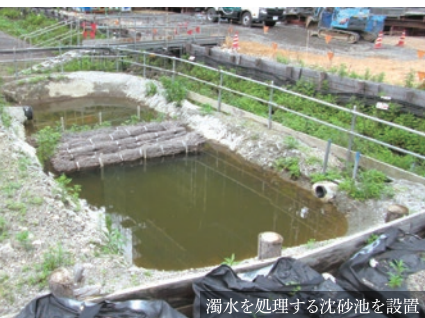
濁水を処理する沈砂池を設置
