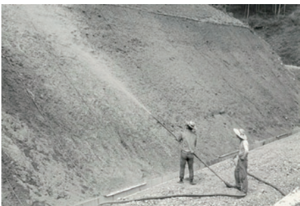
初期ののり面緑化工試験の様子
