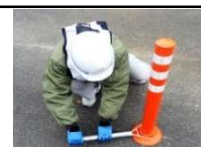
固定ボルト締付確認
