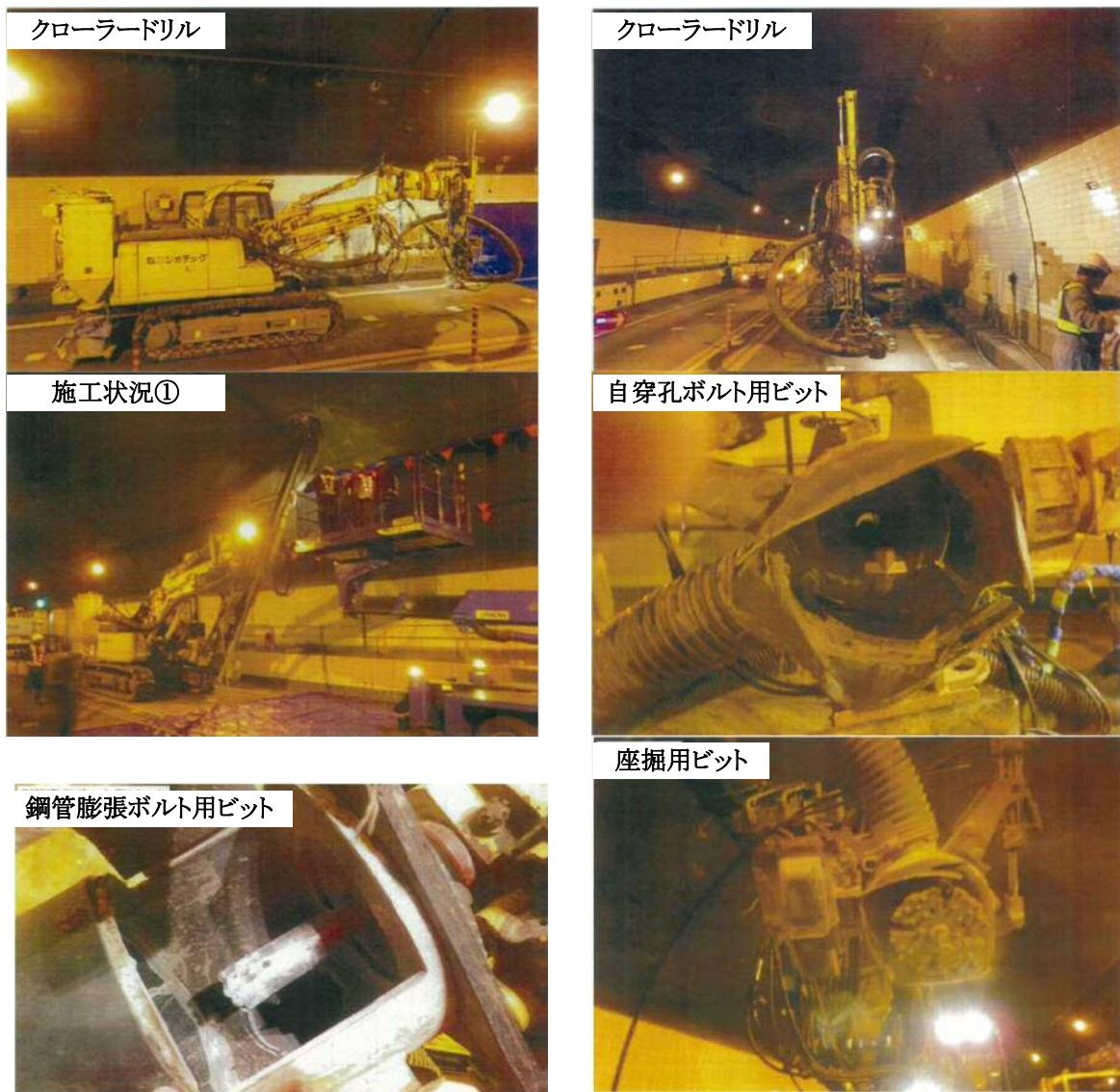
写真 4.1 先行補強工の施工状況写真(通行止めで施工)
