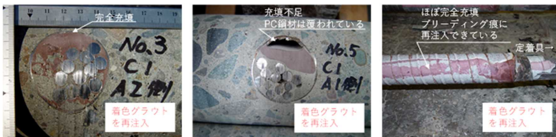
再注入の状況の確認事例
