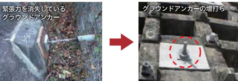
※グラウンドアンカーとは、切土のり面に働く土壌のすべり力を、緊張力を利用して安定させるものです。
