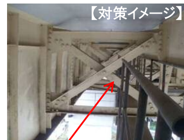
桁補強 (対傾構の増設など)
