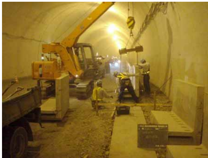
プレキャスト円形水路の据付状況
