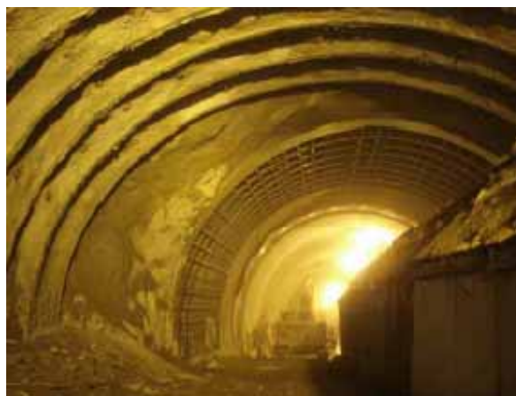
拡幅掘削後の非常駐車帯の様子
