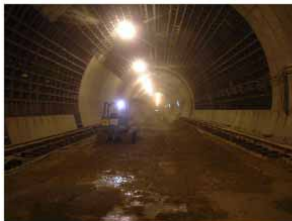
拡幅掘削前の非常駐車帯の様子
