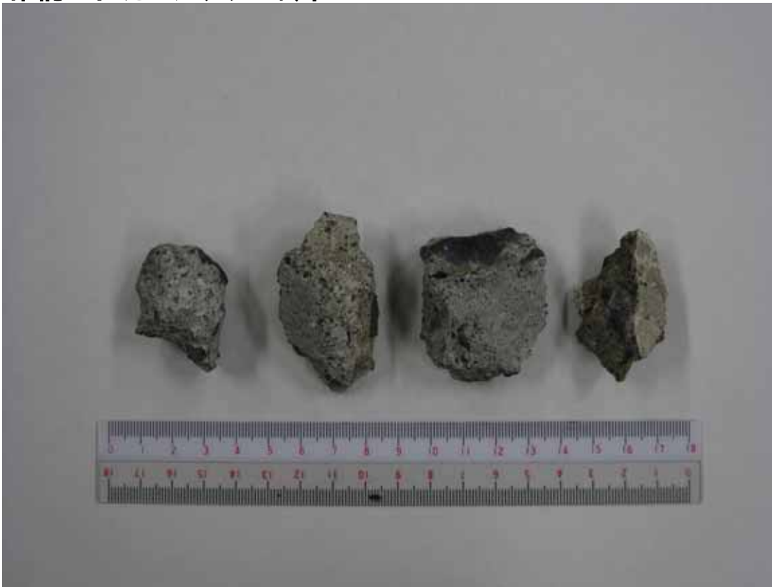
確認されたコンクリート片
