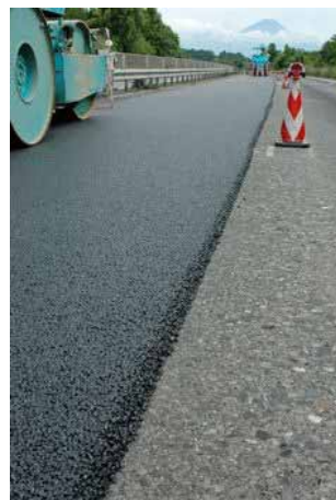
アスファルト舗装敷き均し
