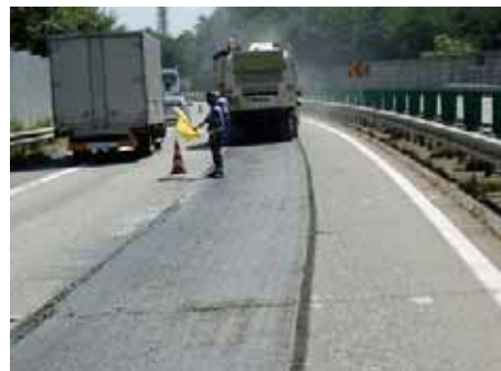
路面切削機による不陸整正工施工状況
