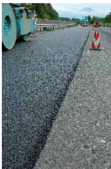
図．アスファルト舗装の敷き均し状況
