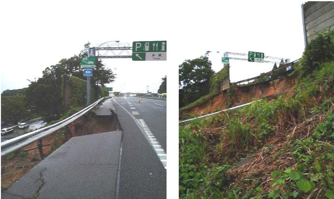
盛土のり面崩落の状況（9月16日撮影）
