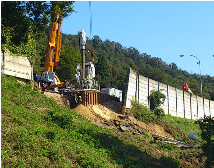
盛土のり面崩落状況（9月18日撮影）
