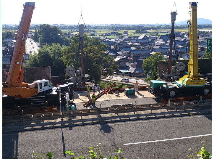
応急復旧工事の状況（9月18日撮影）
