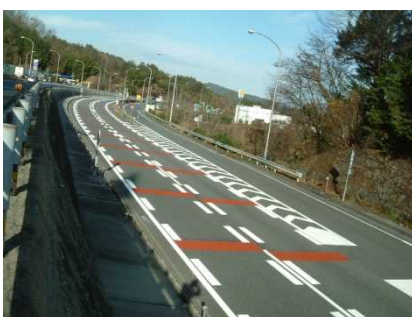
④薄層舗装
