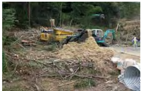
工事用進入路整備
