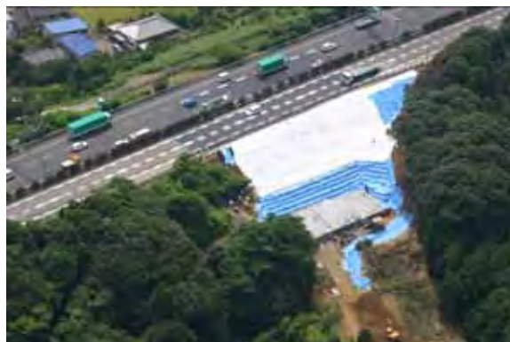
< 応急復旧完了 >
