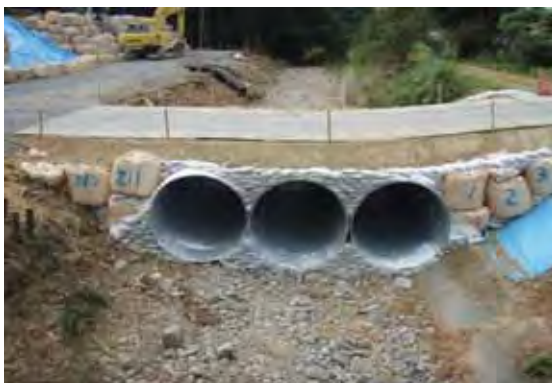
工事用進入路設置（河川部）
