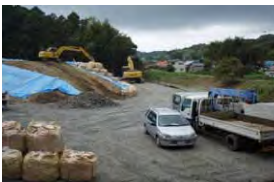
崩落土砂処理（河川近接部）
