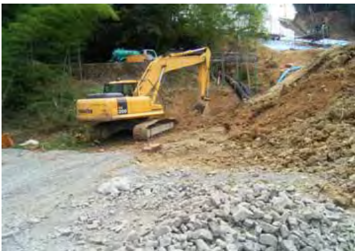
水平ボーリング機械設置箇所整備
