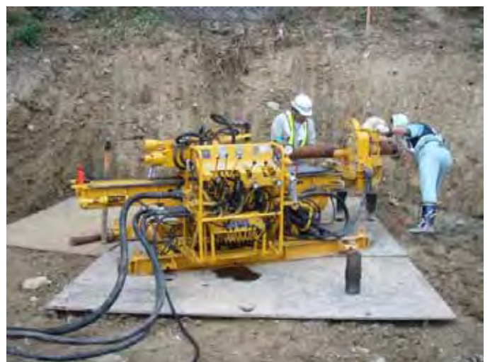
水平ボーリング機械設置
