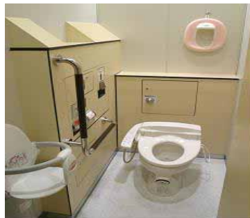
洋式化・洗浄器付便座・増設
