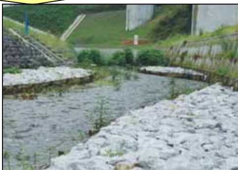
工事完了後（ホタル保全用ブロック約1200㎡） 【2001年】
