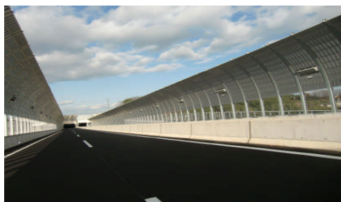
遮音壁設置状況
