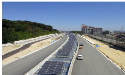
太陽光パネル設置状況
