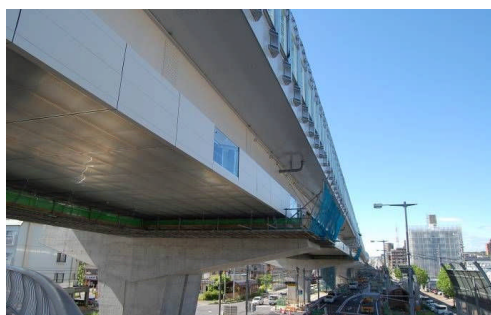
高架裏面吸音板設置状況
