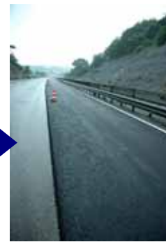
追越側 補修完了
