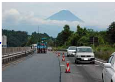
コンクリート舗装補修中
