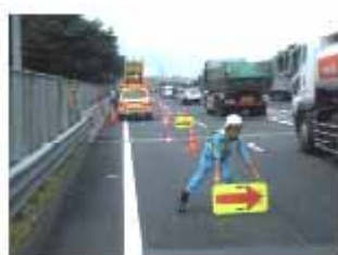
事故処理支援・落下物処理 等に対する交通確保
