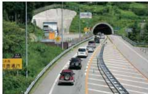
郡上八幡IC付近を先頭とした渋滞が発生
