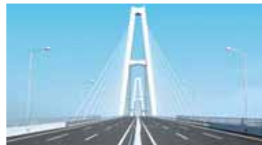
安全・安心・快適な高速道路空間
