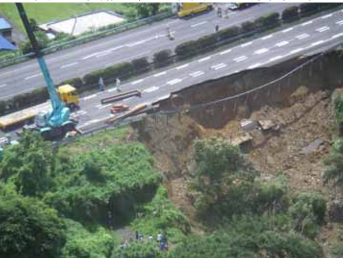
応急復旧工事(上空写真)
