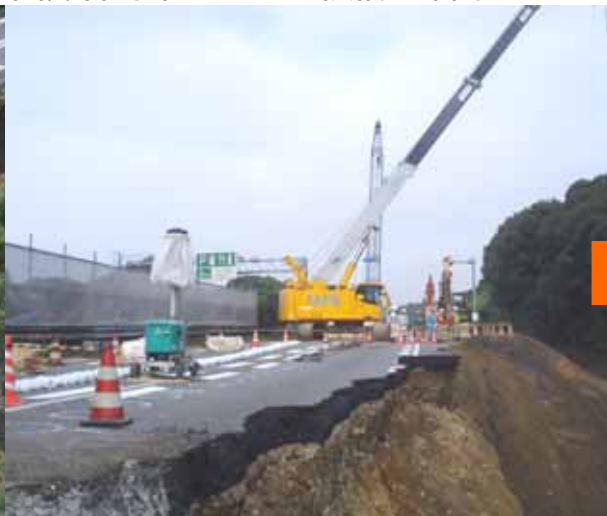
応急復旧工事(近景)
