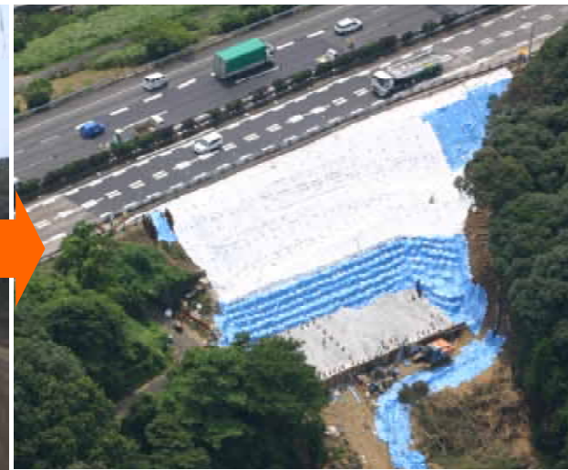
応急復旧完了、通行止め解除
