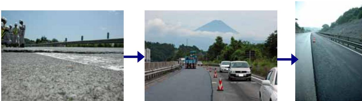
損傷状況：コンクリート舗装の段差      コンクリート舗装補修工事施工中      追越側 補修完了
