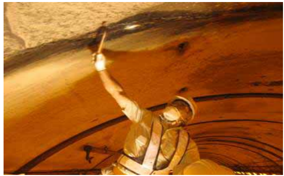
トンネル内の点検
