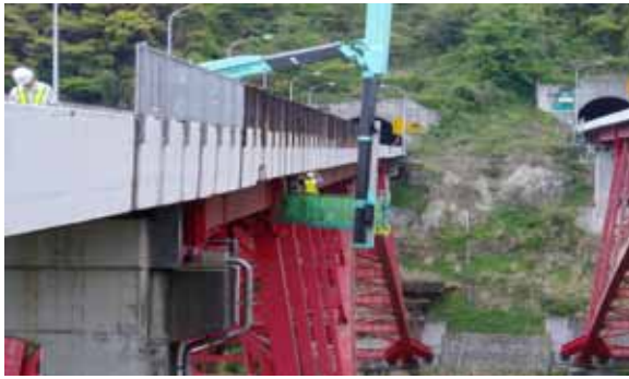
橋梁点検車による点検
