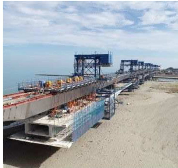
《工事全景(砂浜部)》
