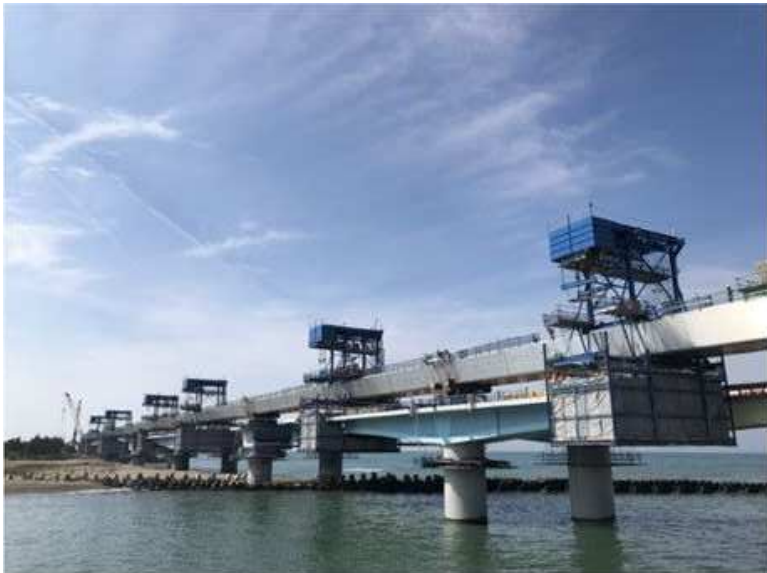
《工事全景(河川部)》
